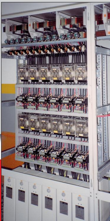
*Equipo automático de compensación de energía reactiva instalado en un Hospital*
